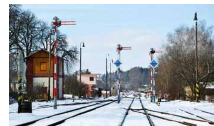
Blick auf die Weichenstraße in Richtung Rostoky/Jilemnice. Im Hintergrund der Stellwerkturnm Stw2
