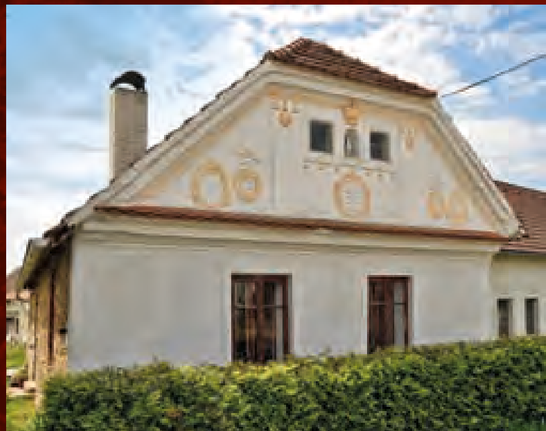
Vlastec (PI), čp. 44, ukázka bohatě zdobeného zvalbeného štítu, ve dvou větévkových terčích letopočet 1868
