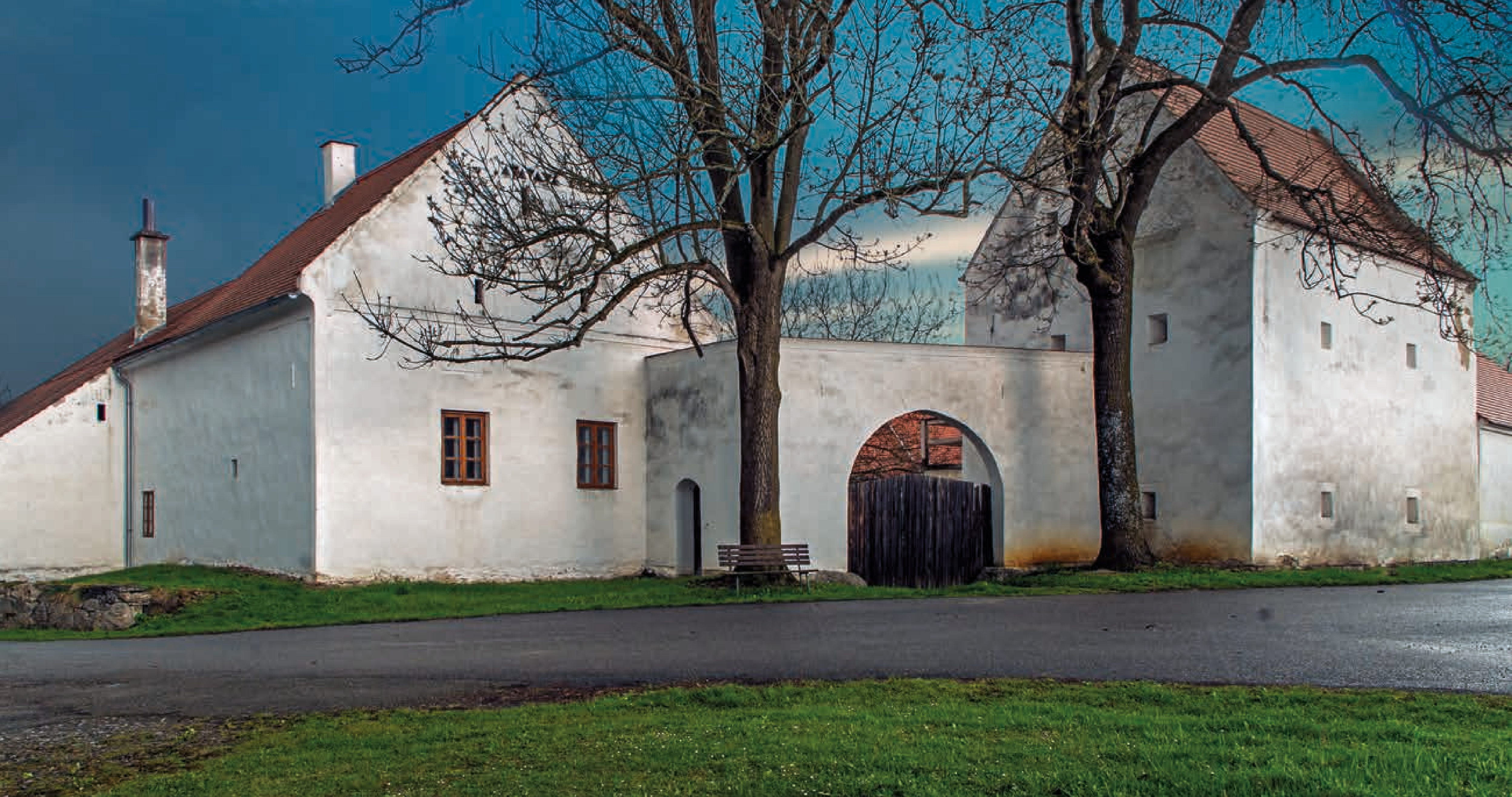
Krnín (ČB), čp. 3, dům špýcharového typu s blokem komorové sýpky otočeným do návsi, v podkroví je dochována dřevohlinitá konstrukce chránící podkroví před požárem – tzv. lepenec, dendrochronologická analýza 1502/1503 a 1505/1506, špýchar počátek 17. století
