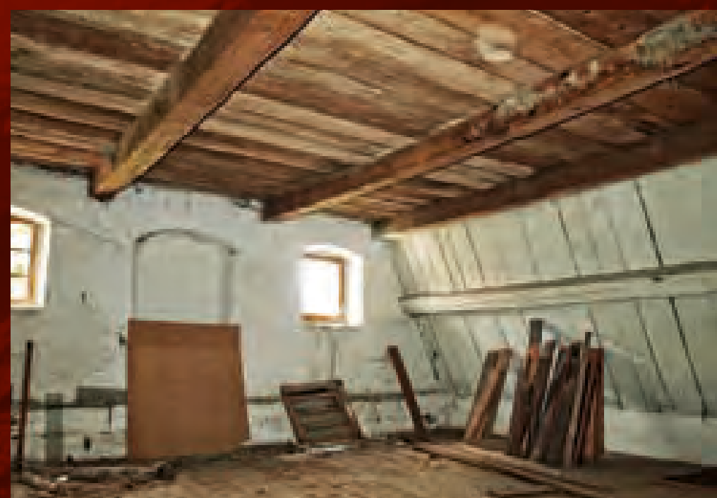
Holašovice (ČB), čp. 3, interiér podstřešního prostoru tvořeného konstrukcí lepence
