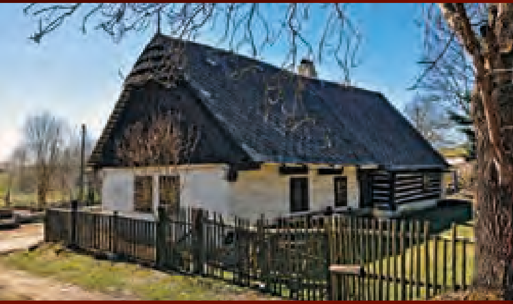
Pohořelice (TA), čp. 1, jeden z nejvýznamnějších obytných roubených domů v oblasti Cunkovského hřbetu, trojdílná dispozice s rozšířeným komorovým dílem, štít s bedněnou lomenicí završený kabřincem s makovicí
