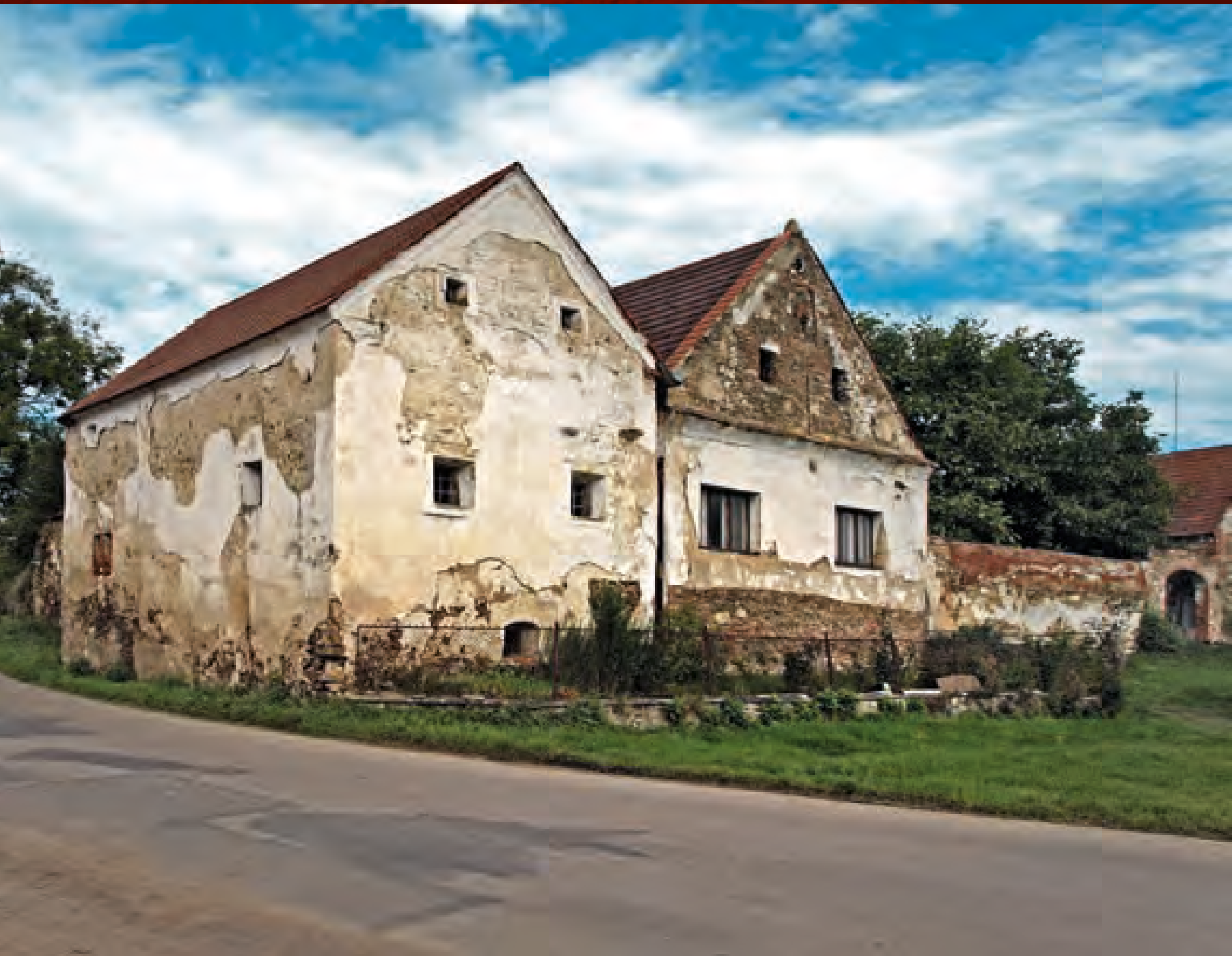
Horní Třeboňín (ČK), čp. 1, mohutná, v nárožní poloze situovaná sýpka středověkého původu s interiérem upraveným k obytným účelům, hlazené pasparty oken ve štítě, vlevo od domu brána s klenutým vjezdem a malovanou výzdobou z první poloviny 16. století
