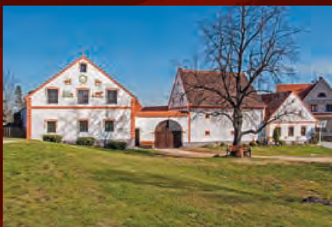
Holašovice (ČB), čp. 22–39, usedlost s obytným stavením vlevo, pokračující vjezdovou bránou, navazující okapově orientovanou sýpkou a štítovým průčelím výměnku vpravo
