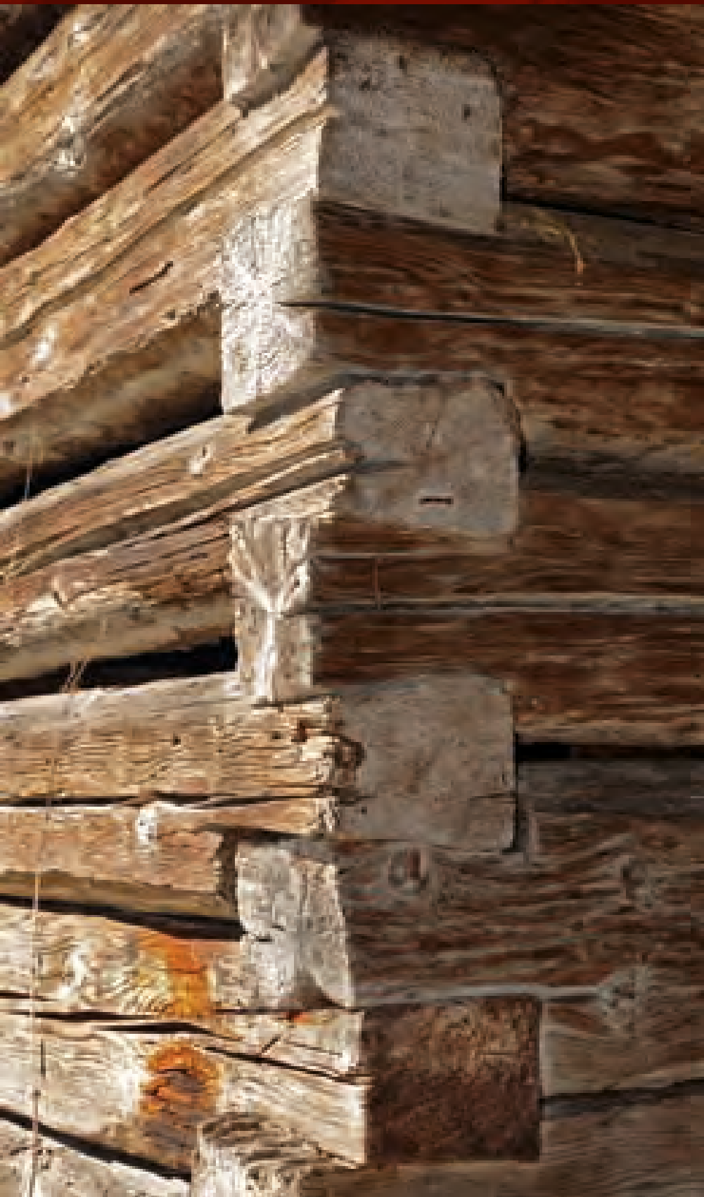
Nosetín-Chaloupky (PI), čp. 10, detail roubení komory s rohovou vazbou (rybinou)
