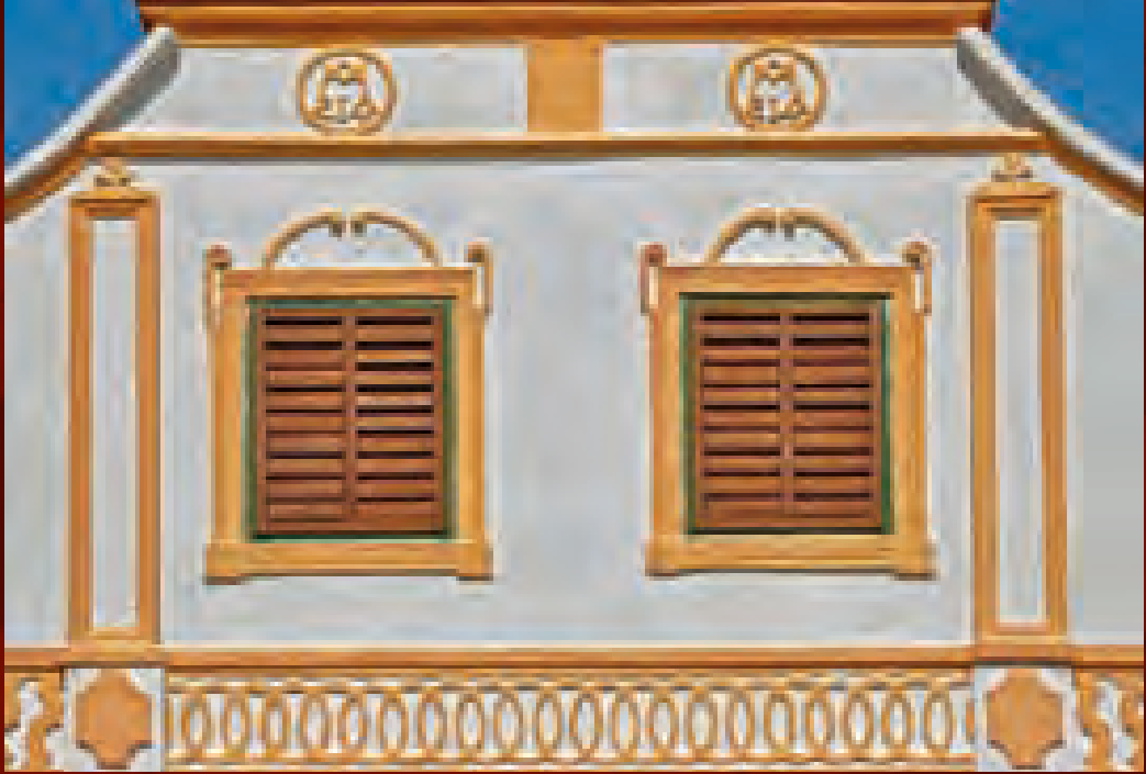
Zbudov (ČB), čp. 27, členění štítu pilastry, vlisy v podobě slepých balustrád a protínajících se kroužků, štukové okenní šambrány
