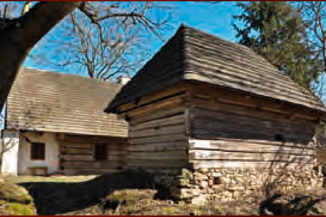
Nosetín-Chaloupky (PI), čp. 10, roubený dům a roubená komora
