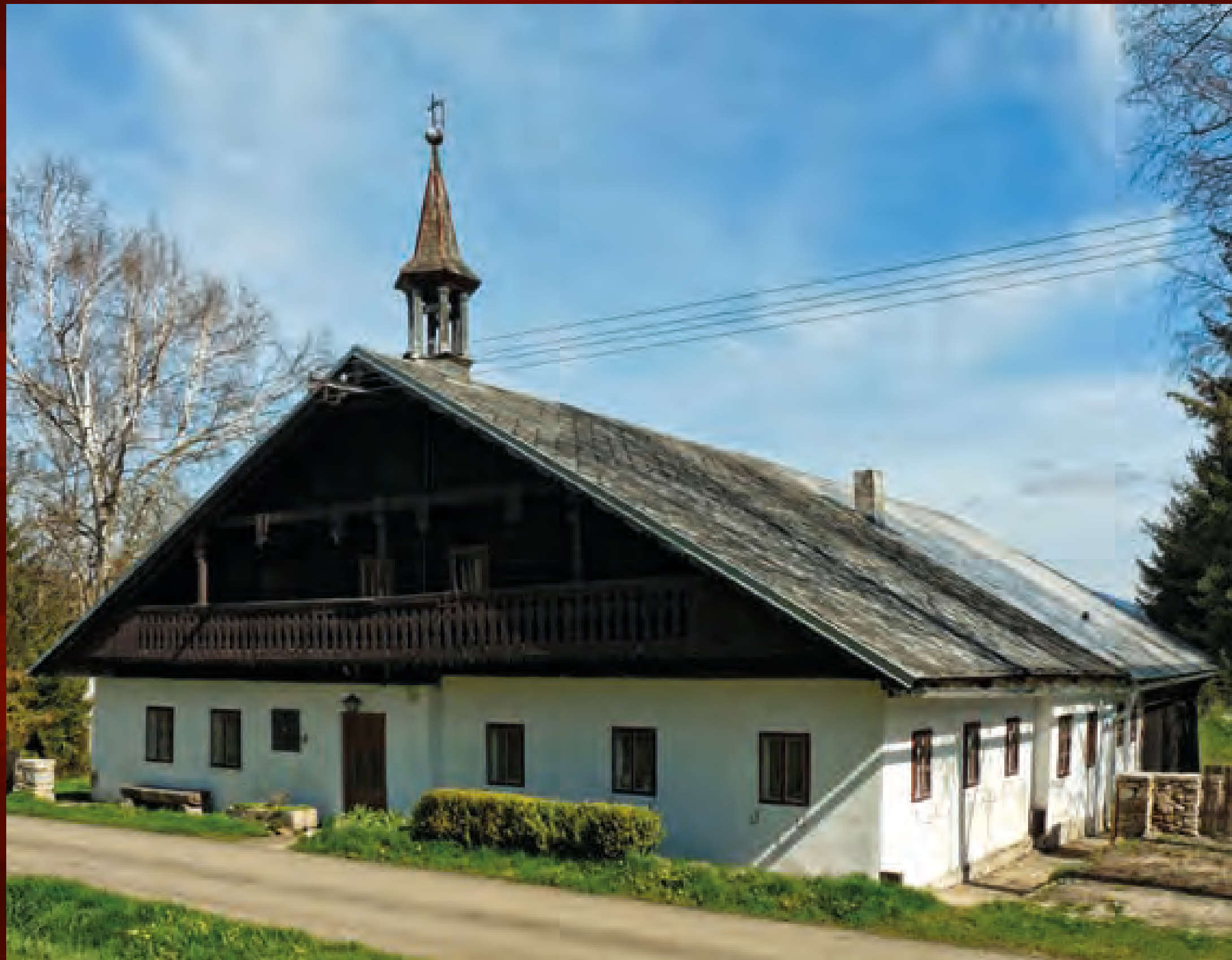
Dobrá (PT), čp. 10, jediný ve vsi dochovaný dům ve volarské dispoziční skladbě, ke komunikaci orientován štítovou stranou, po pravé straně roubená světnice v kožichu, v zadní části hospodářské prostory, pod střechou roubená světnička
