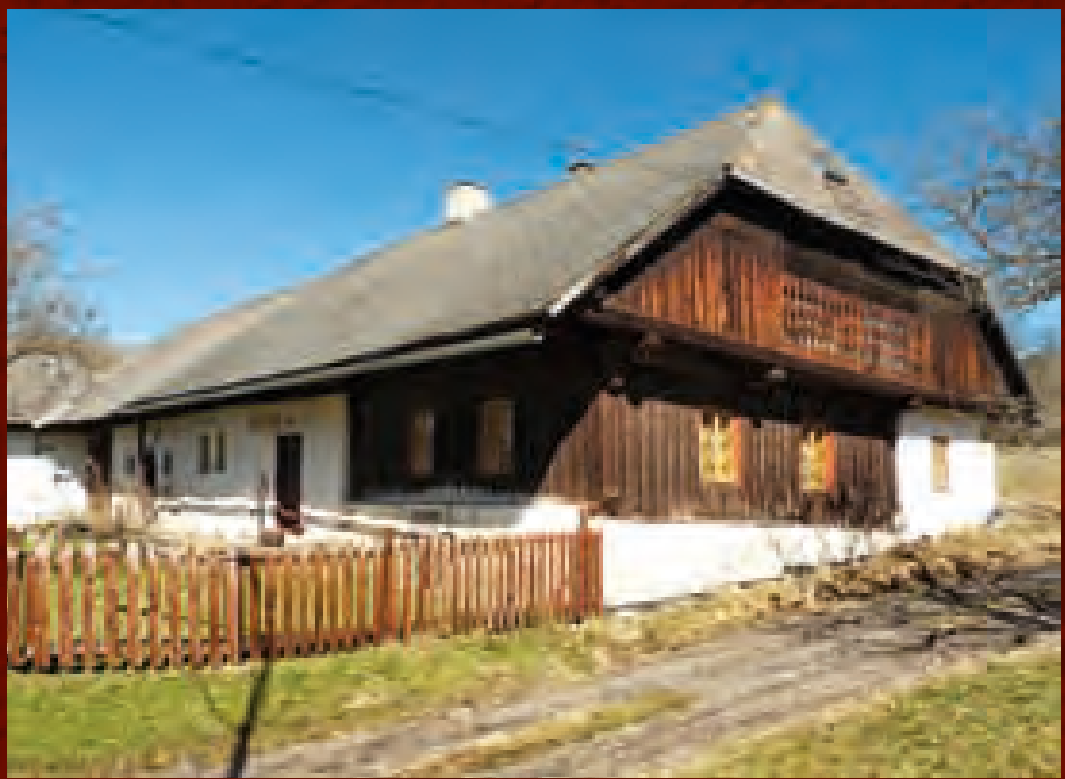
Stachy (PT), čp. 64, klasický šumavský dům, ve štítu široké polovalbové střechy malá vyřezávaná pavlač (dnes zaslepena)
