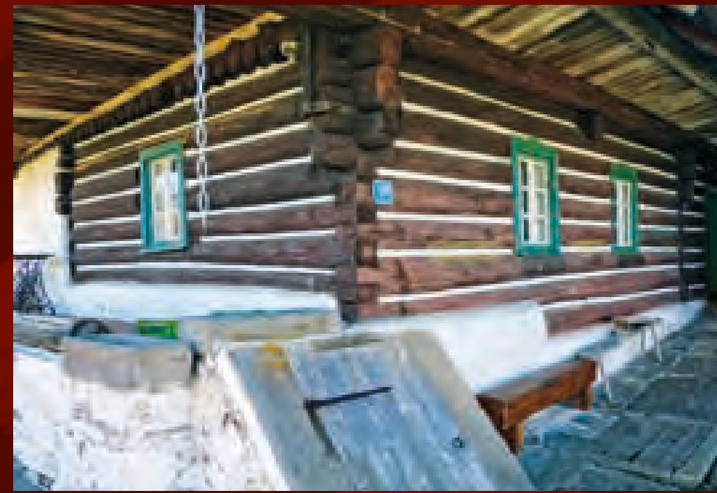
Říhov (PT), čp. 52, detail roubení s rohovou vazbou a vstup do sklepa
