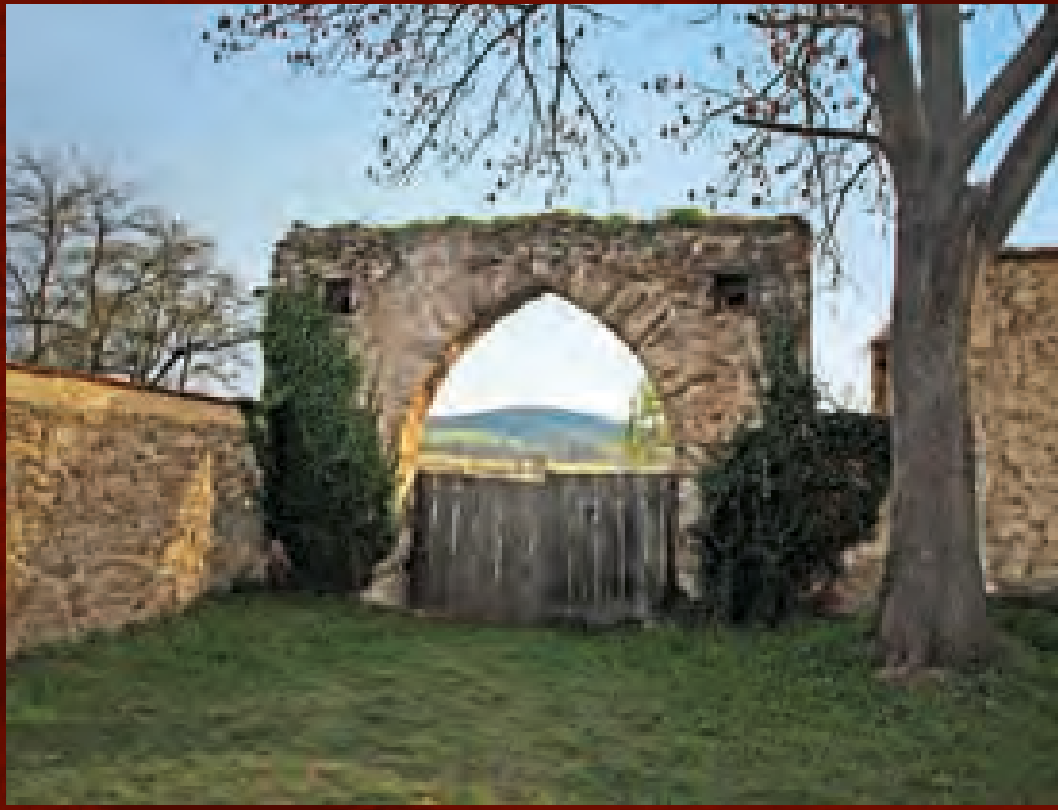
Čertyně (ČB), čp. 9 a 10, vjezdová brána zaniklé usedlosti, archaická konstrukce s lomeným obloukem
