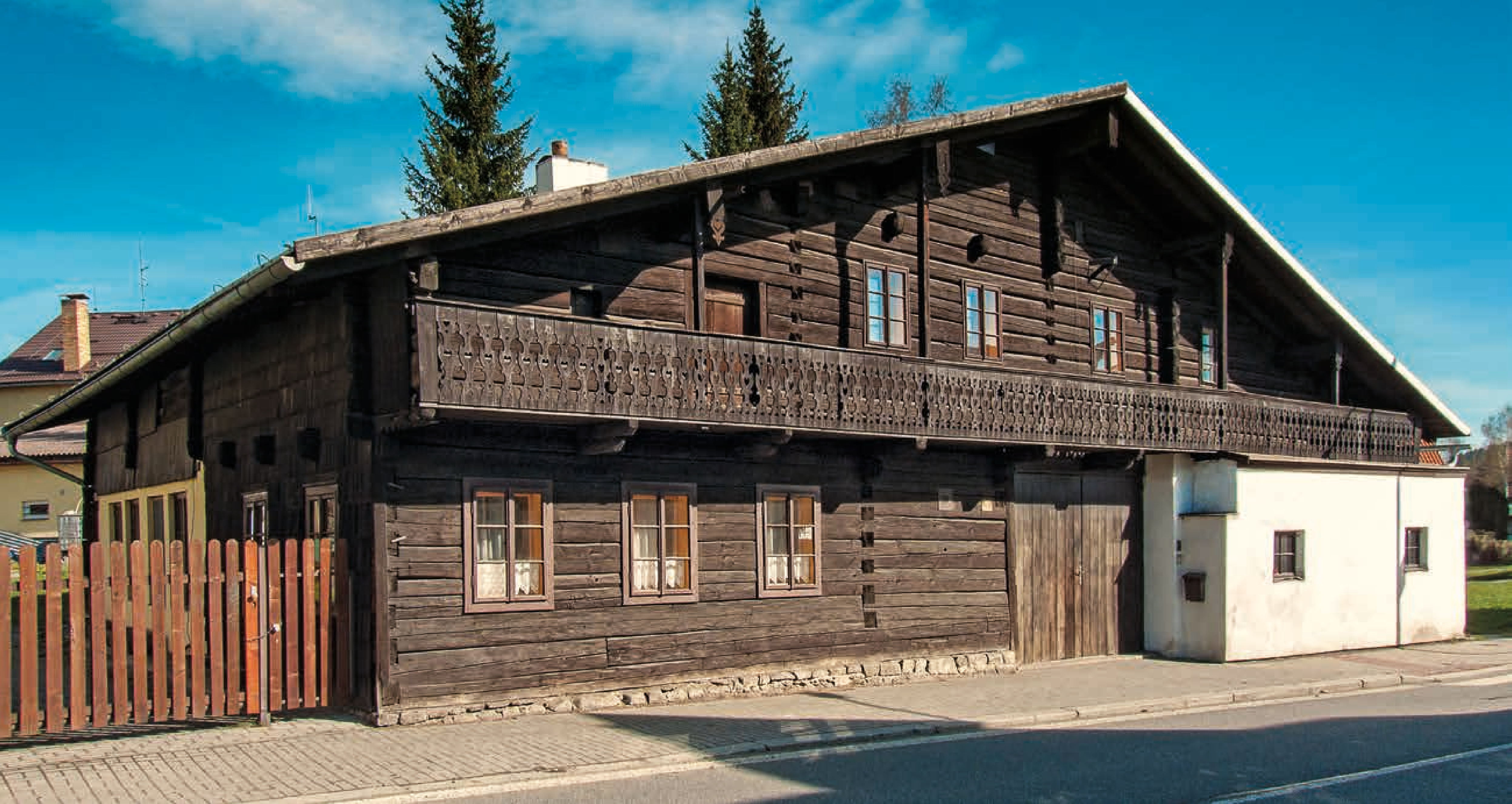
Volary (PT), čp. 42, netypická průjezdní dispozice, po levé straně širokého průjezdu světnice, v čele domu po pravé straně zděná stáj, v zadní části stodola
