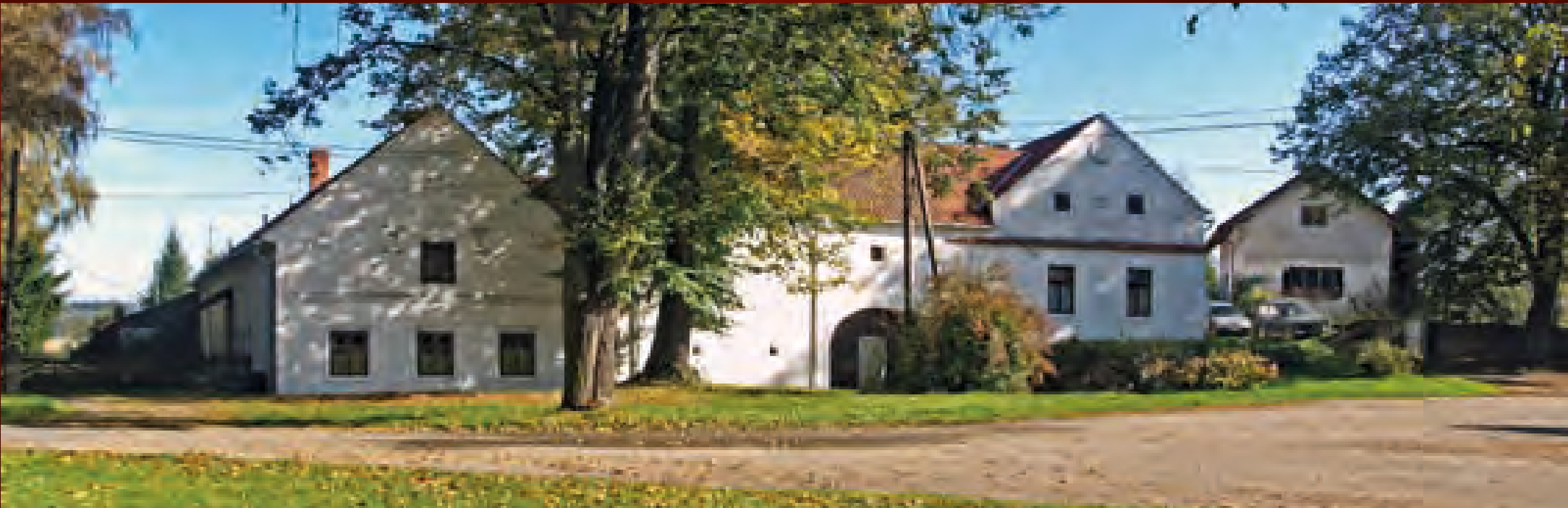
Prostřední Svínice (ČK), čp. 7 a 8, štítově orientovaná usedlost s domem a výměnkem při návesním průčelí z 19. století, hospodářská budova s průjezdem do dvora a vlevo špýchar, v areálu pozůstatky velmi staré patrové sýpky
