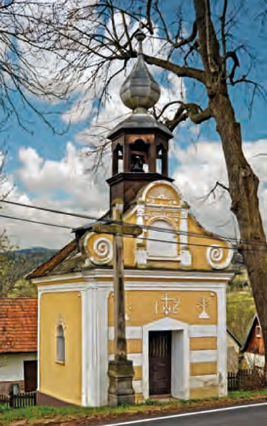
Libotyně (PT), kaple Panny Marie s Bursovou řasádou, datace 1844
