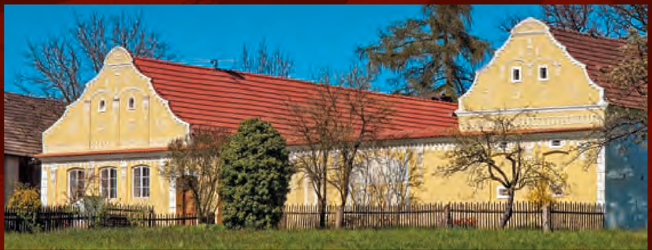
Vlastiboř (TA), čp. 36 s bohatou výzdobou štítu obytného stavení i sýpky, symetrické řešení s iluzivní bránou v ohradní zdi, sýpka vpravo postavena v jednotném stylu až roku 1924
