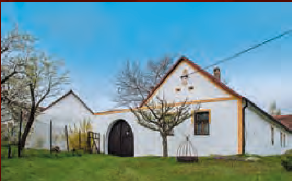
Hůrka (ČB), čp. 8, štítově orientovaná usedlost se střízlivou výzdobou, lizénové rámování plochých šambrán kolem oken, kapličková nika se soškou Panny Marie, oválný rámeček s letopočtem 1861
