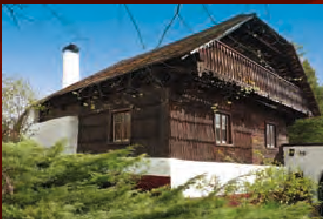
Lažiště (PT), čp. 15, spojení šumavského a špýcharového domu, roubená světnice vyvýšená nad klenutým sklepem, síň s černou kuchyní a patrový špýchar, přístupný ze síně i z vnější pavlače
