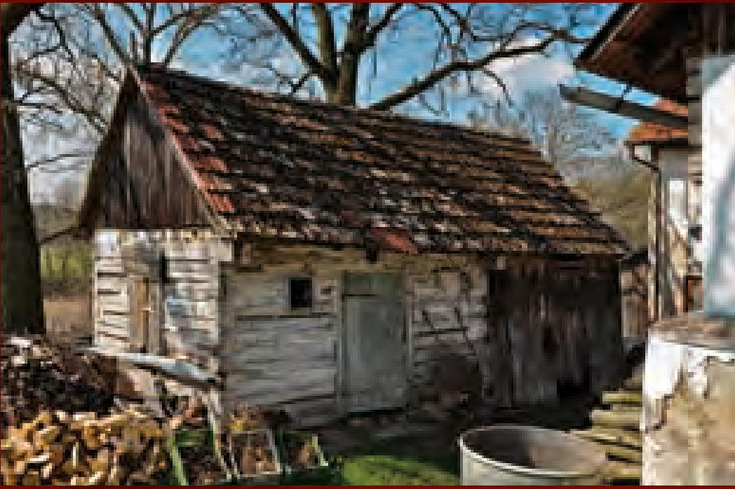
Kotýřina (PI), čp. 8, roubená komora v usedlosti, kde se částečně dochoval roubený dům s mladšími úpravami
