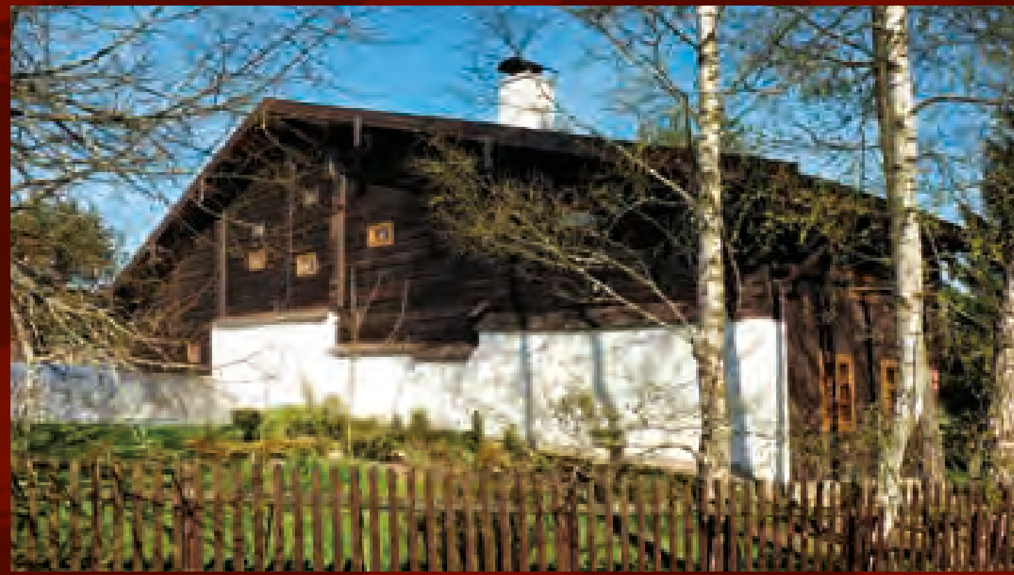
Volary (PT), č. ev. 10, usedlost obracející se k ulici delší boční stranou, nad níž vznikl štít
