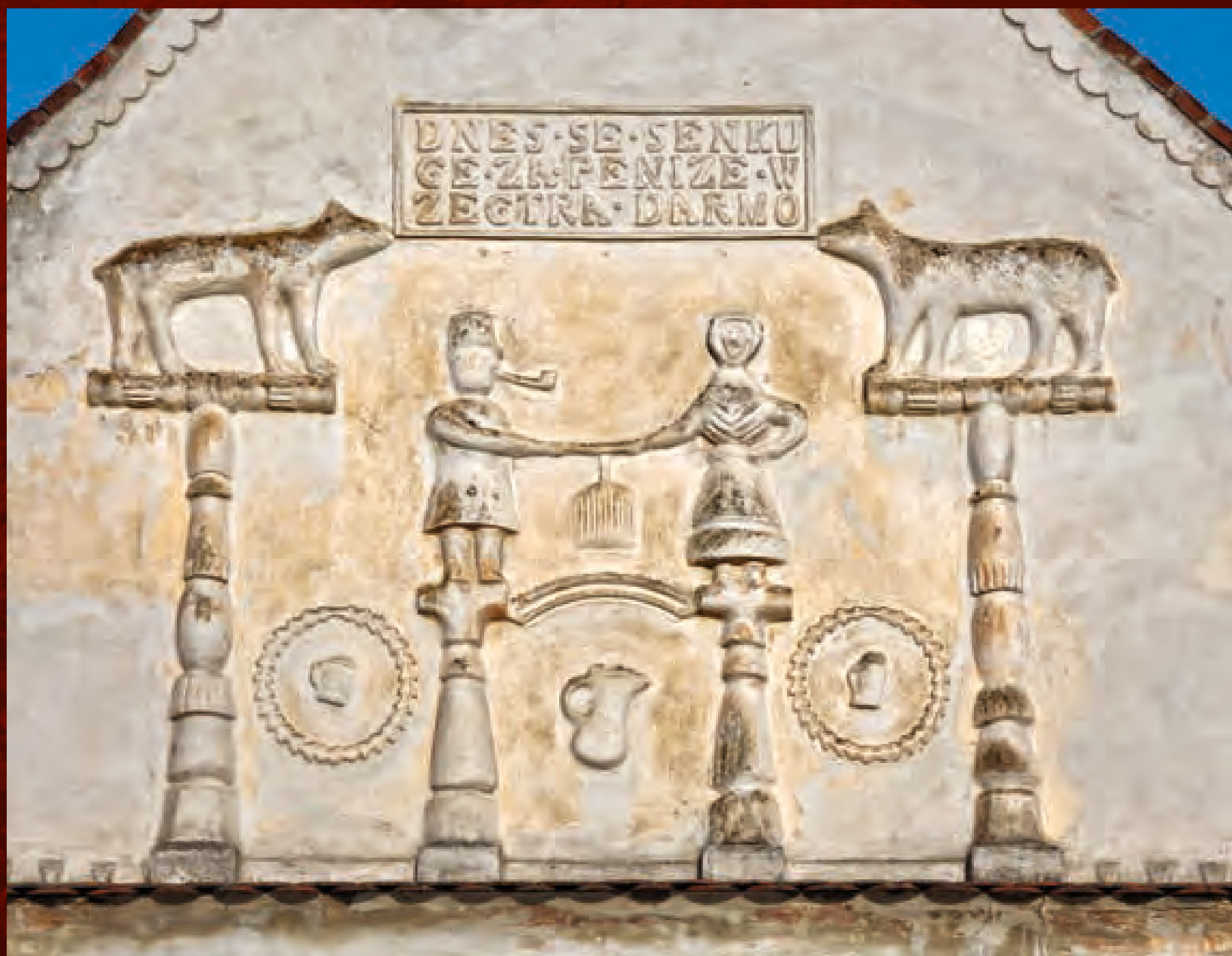
Míloňovice (ST), hospoda čp. 4, netektonická štuková výzdoba štítu s nápisem napovídajícím účel objektu
