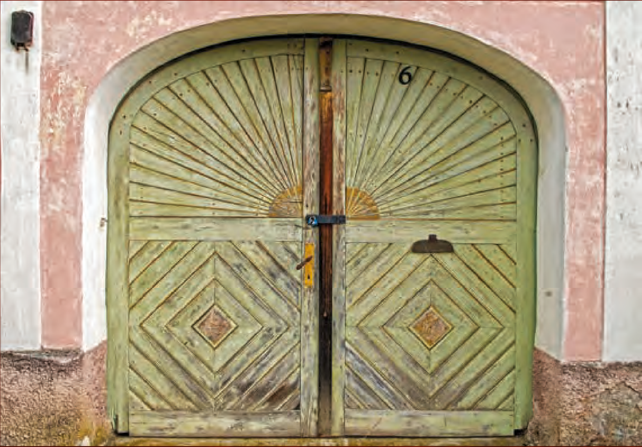
Božejov (ČB), ép. 30, vrata průjezdu se složitou skladbou plochého rámového pokryvu z doby po polovině 19. století.
