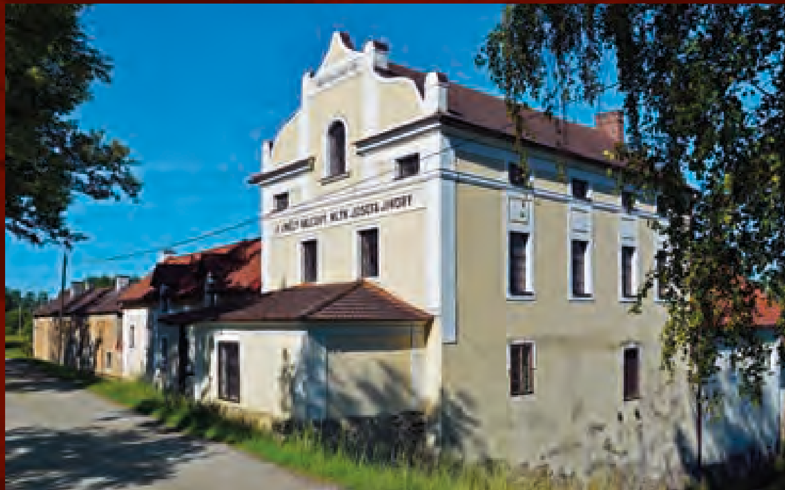
Třeboň (JH), obecní (Jindřův) mlýn čp. 247, původně renesanční mlýn upravený v 19. století na tzv. umělecké složení mlecího zařízení
