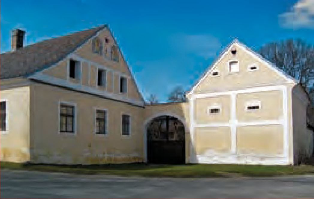
Dolní Nakvasovice (PT), řp. 9, průřelí obytného domu a řpýcharu s Bursovými řtíty, datace 1847
