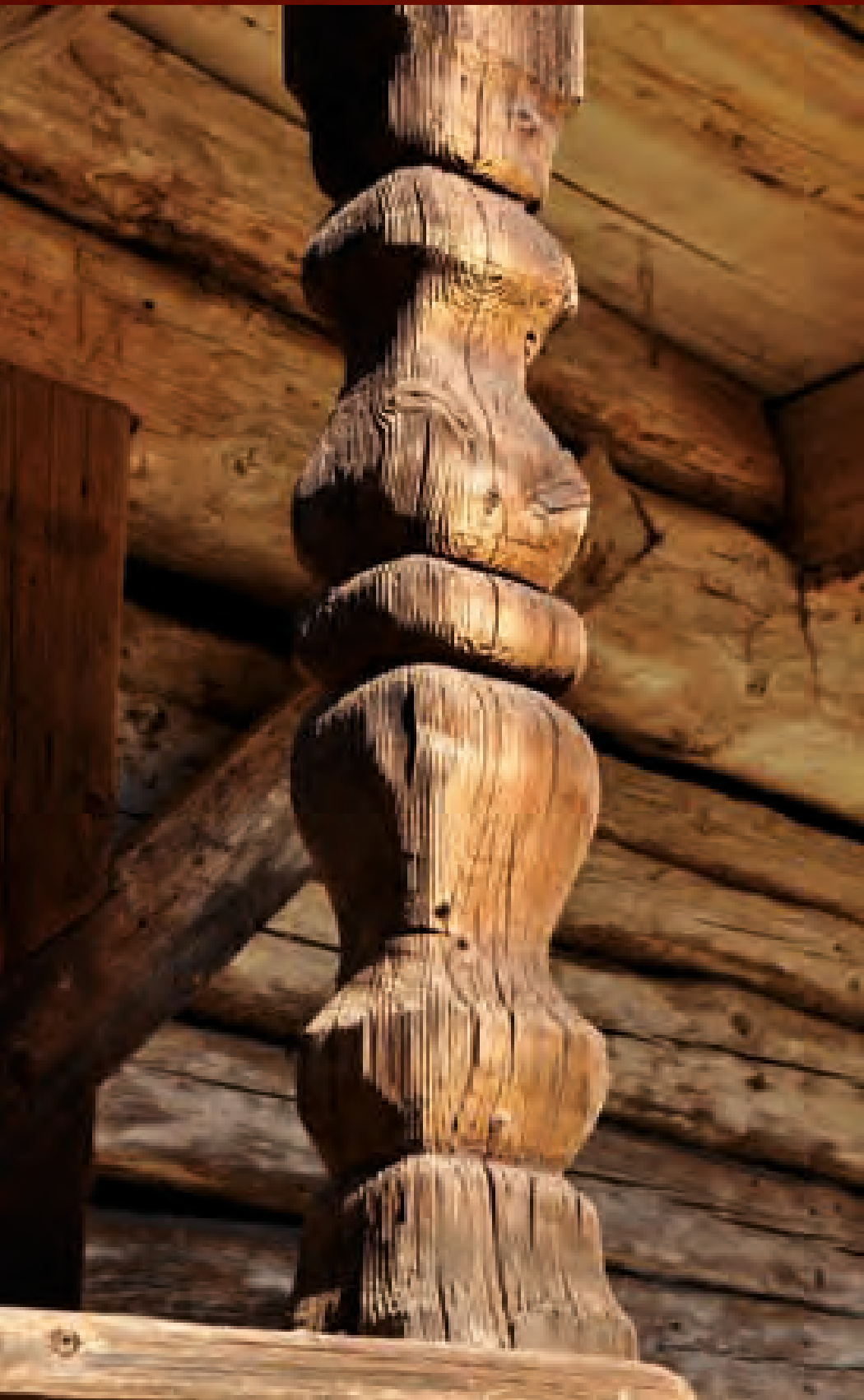
Zhoř (PI), čp. 9, špýchar s roubenými komorami, detail vyřezávaného sloupku pavláčky
