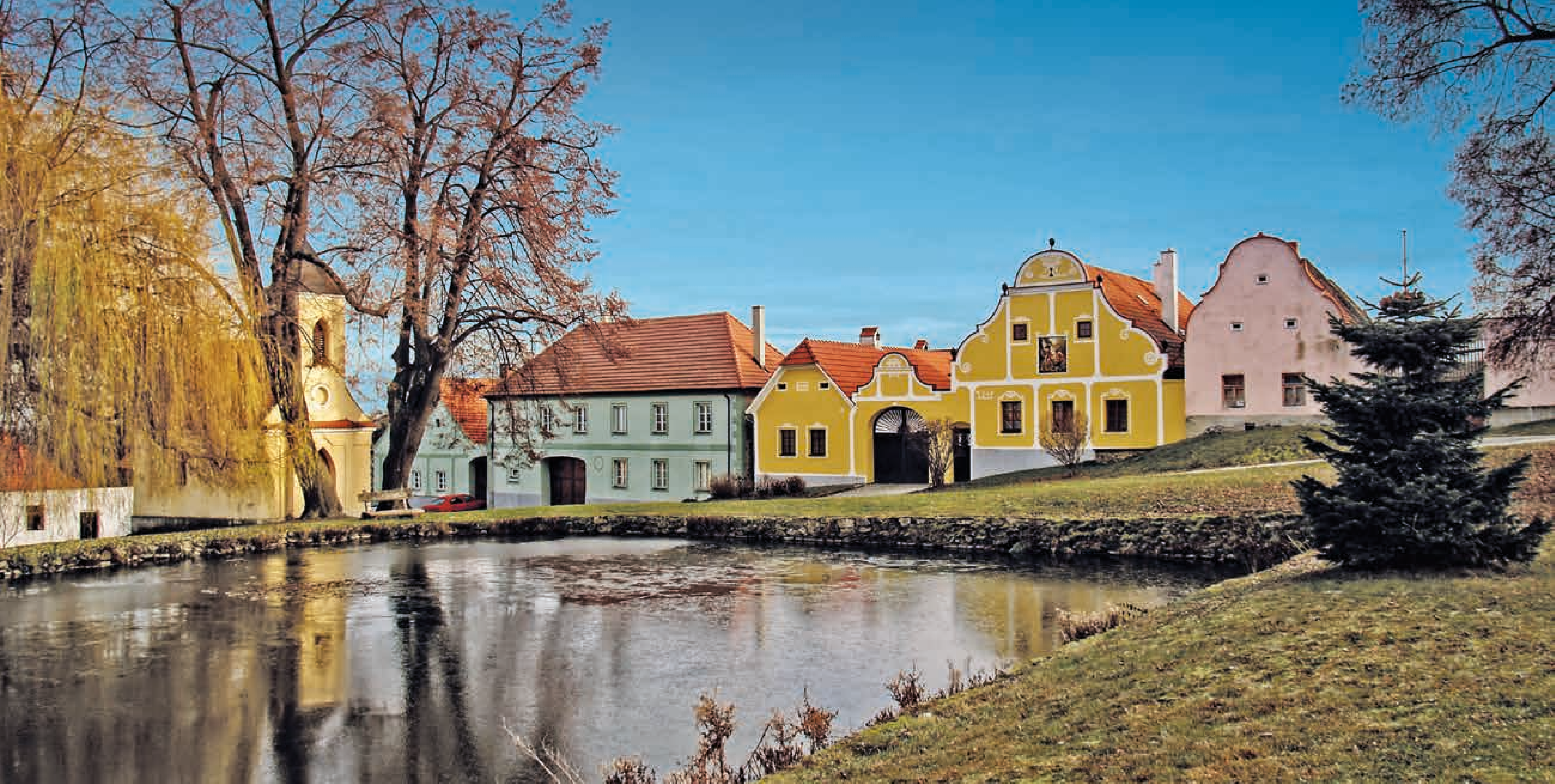
Dobčice (ČB), jižní fronta návsi, čp. 3, 28, 4 a 5, seskupení hmotové a dekorové rozdílných stavení typické pro podhůří Blanského lesa, též vodní nádrže v prostoru návsi
