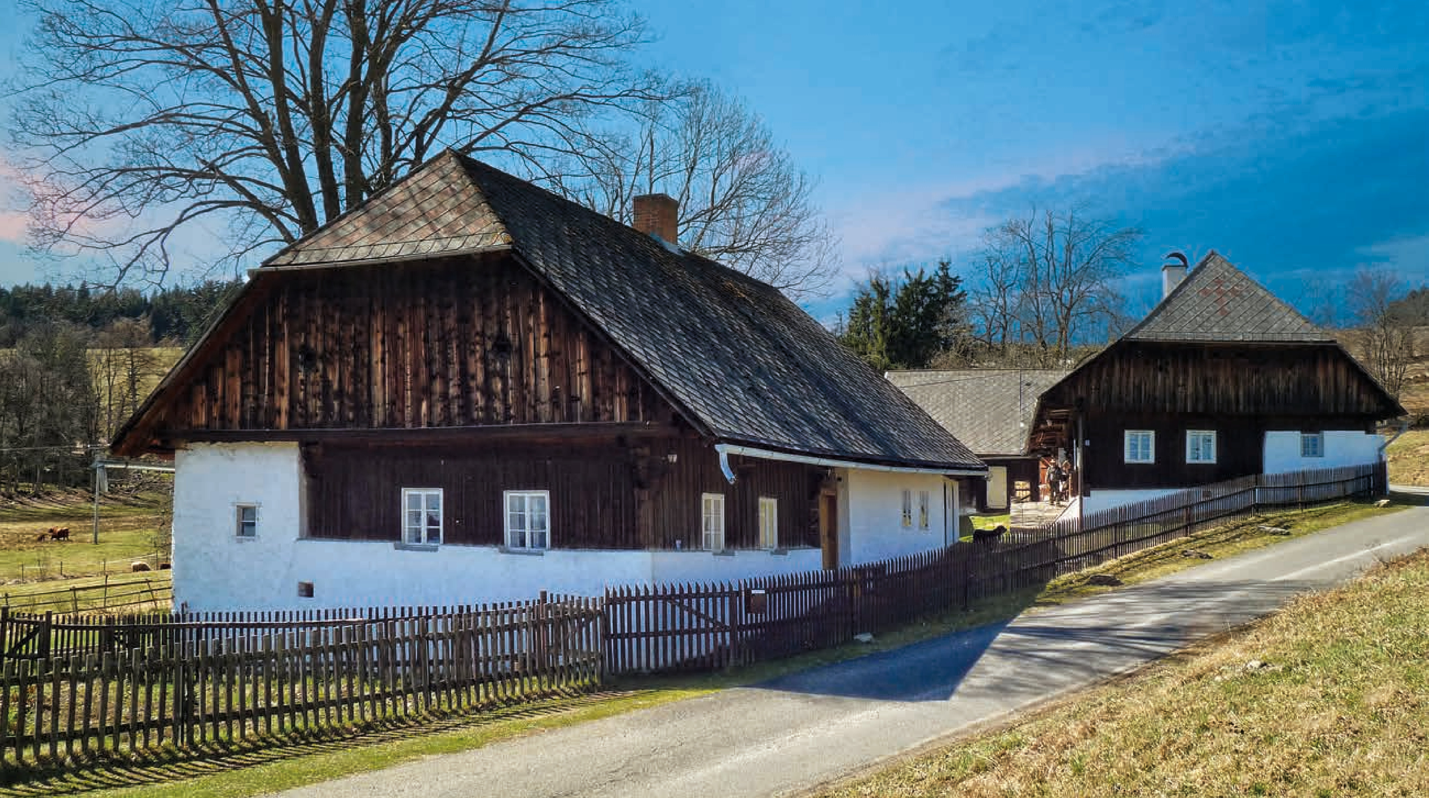
Michalov (PT), čp. 95 a 96, dvojice klasických šumavských domů, v přední části roubená světnice obložená prkny, ve druhém traktu zděná komora, navazující síň s černou kuchyní, v zadní části stáje
