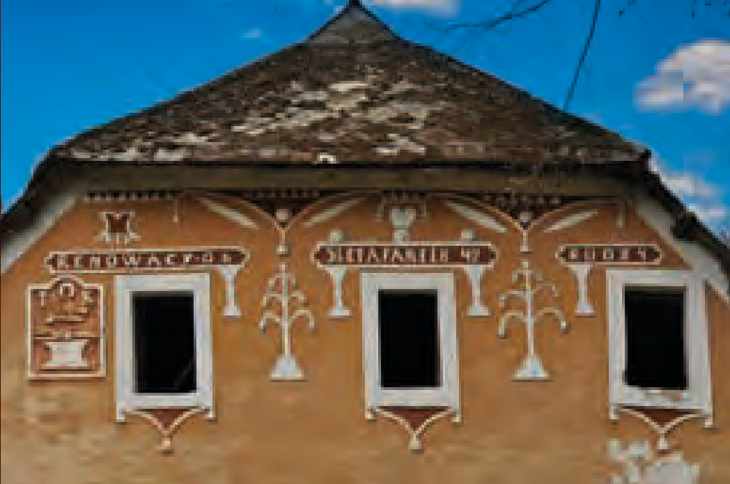
Libotyně (PT), řp. 24, řtít bývalé kovárny s Bursovou výzdobou, datace 1842
