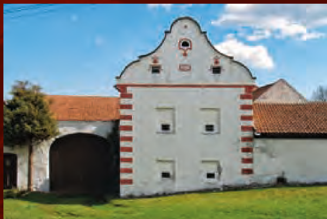
Rojšín (ČK), čp. 21, patrová sýpka s křídlovým štítem a drobnou štukovou výzdobou, datováno 1861
