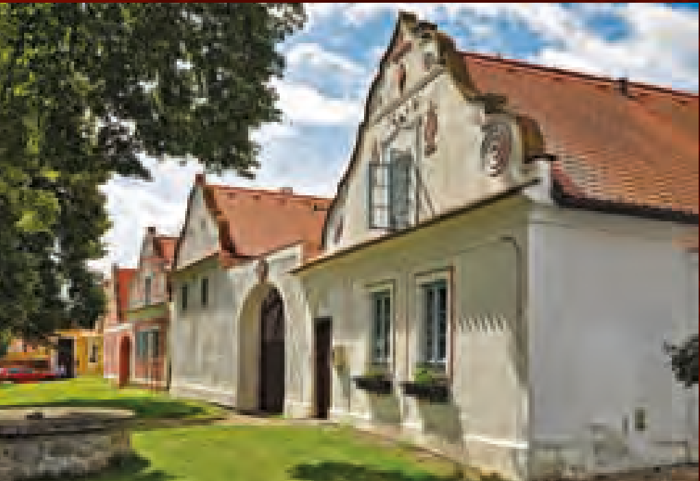
Malé Chrástany (ČB), průčelí statků čp. 4 a 5 na západní straně návsi
