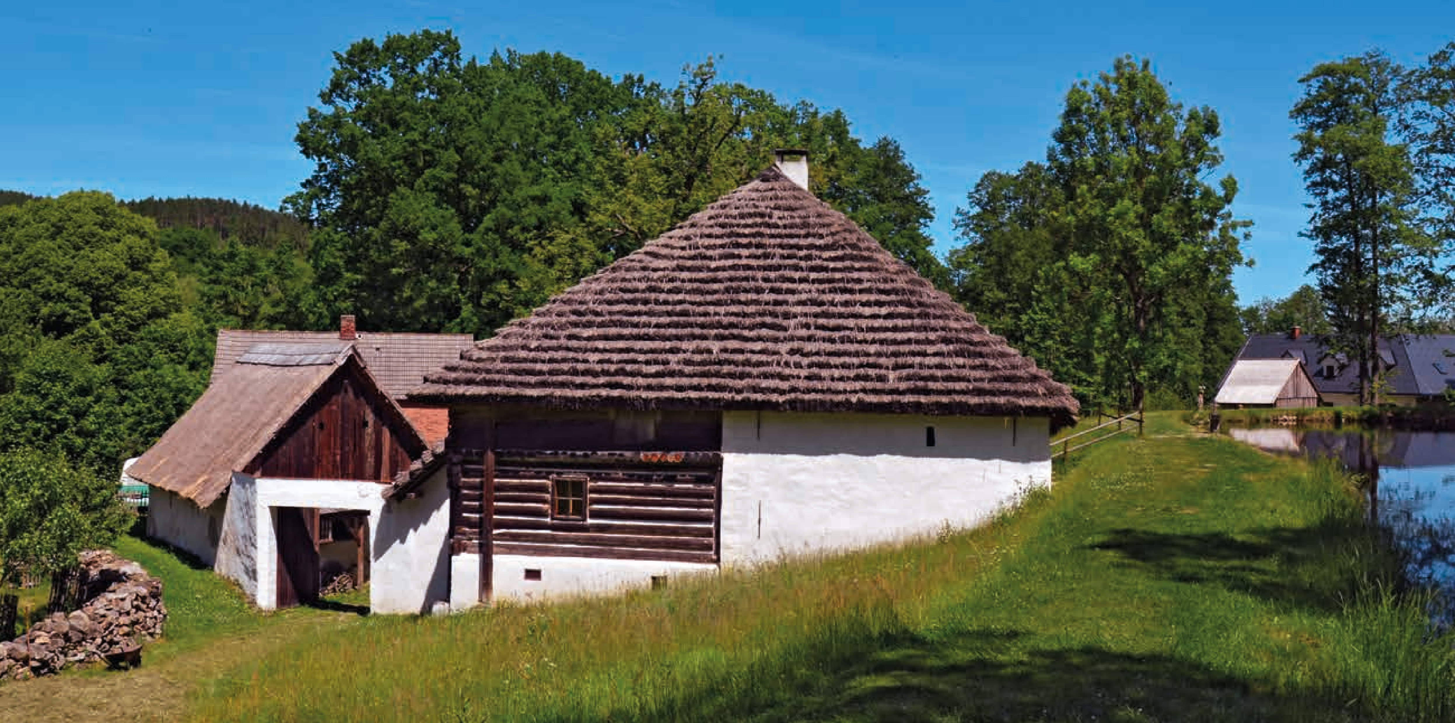
Hoslovice (ST), vodní mlýn čp. 36, částečně roubený areál mlýna vybavený tradičním složením mlecího zařízení na horní vodu
