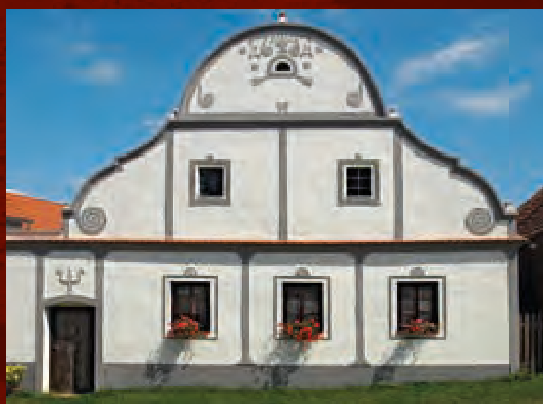
Holašovice (ČB), čp. 3, průčelí obytného stavení se štukovou výzdobou
