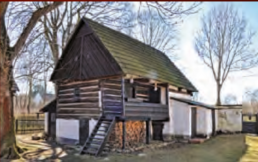
Ounuz (TA), čp. 3, samostatně stojící sýpka (pohled ze dvora), zděné přízemí, v patře dochovaná roubená komora s pavláčkou na boční straně a vstřícně bedněnou lomenicí ve štítě
