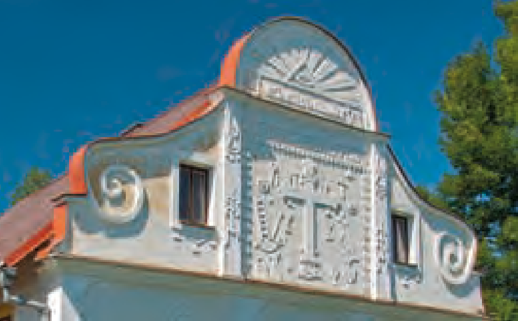
Libotyně (PT), řp. 6, detail řtítu obytného domu usedlosti se řtukovou výzdobou od Jakuba Bursy (mj. nástroje Kristova umučení), datace 1845
