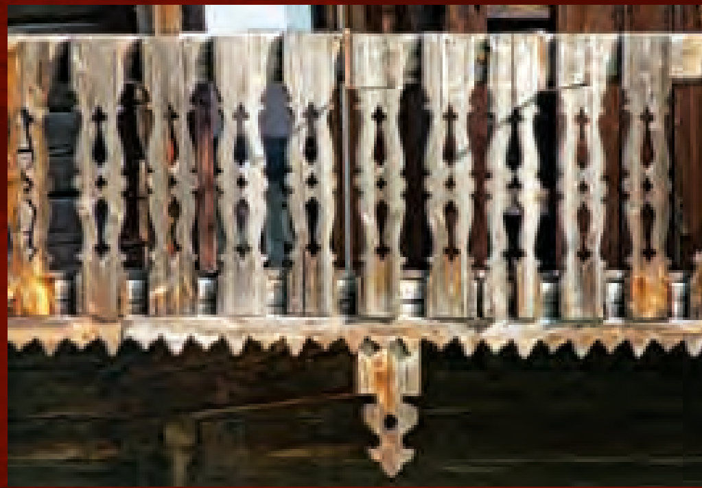
Volary (PT), čp. 102, detail zábradlí
