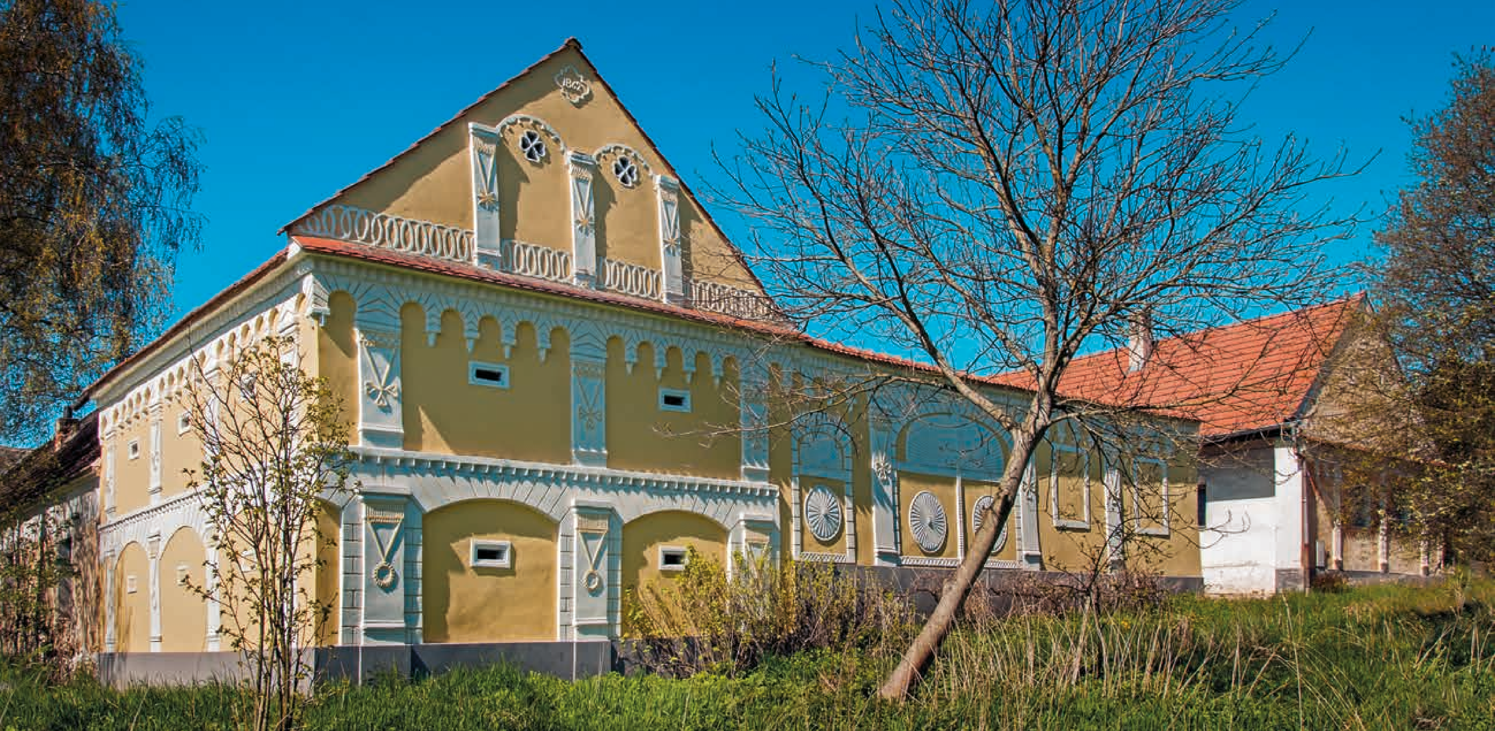
Vlastiboř (TA), čp. 34, štít sýpky a navazující ohradní zeď s iluzivní bránou a brankou, 1862, pozůstatek symetricky pojednaného průčelí, skutečná brána poblíž obytné části byla již zbořena
