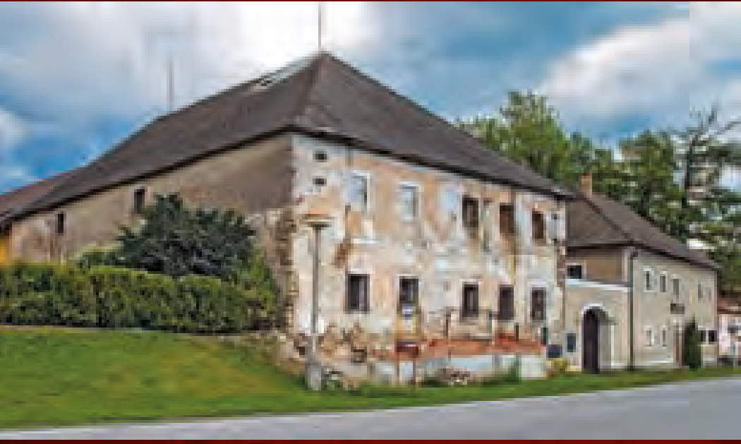
Pihlov (ČK), č. ev. 44, trojstranná usedlost s mohutným zděným patrovým domem
