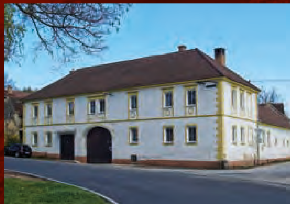
Mříc (ČK), čp. 16, podélně orientovaná patrová usedlost na jihovýchodním konci návsi, datováno 1885
