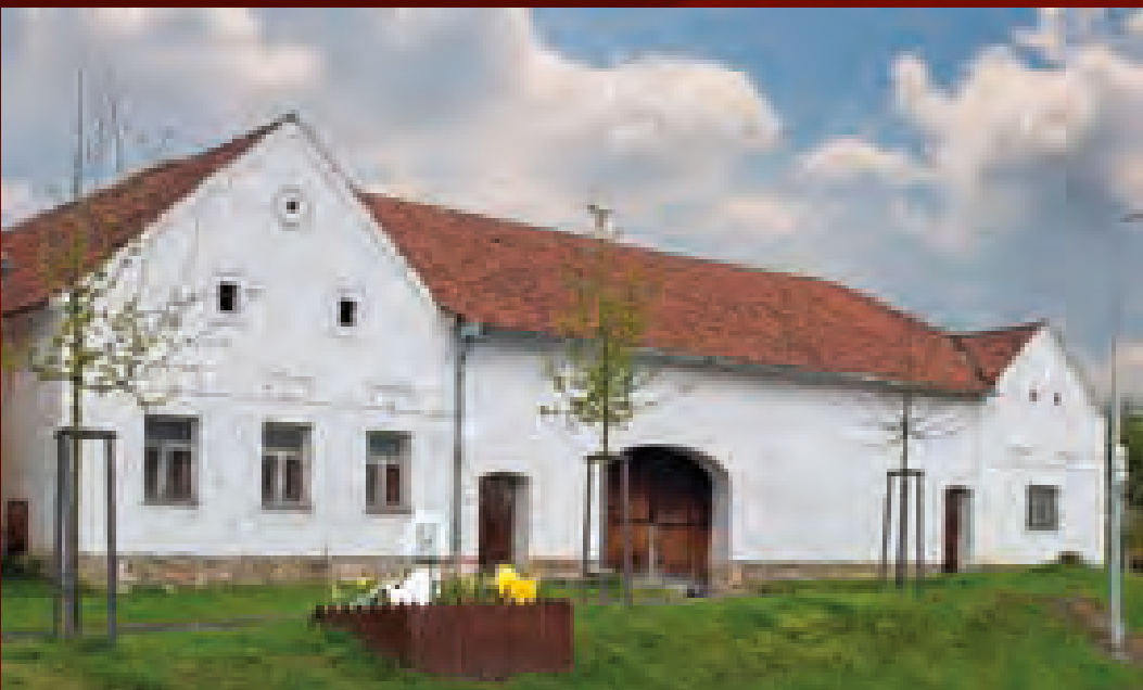
Nedabyle (ČB), čp. 11 a 55, štítově orientovaná usedlost s domem vlevo a výměnkem vpravo, mezi obytné části vložena hospodářské budova s průjezdem a dvěma brankami, průčelí je vertikálně členěno nárožní rustikou
