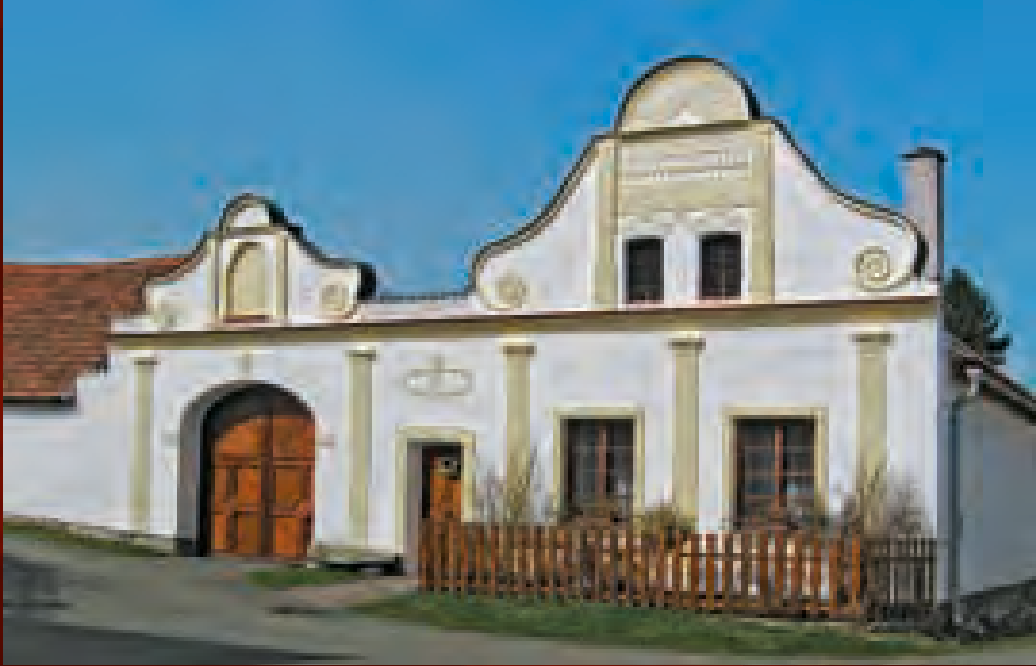
Buřanovice (PT), řp. 27, Bursova výzdoba průřelí obytného domu a brány usedlosti, datace 1844, druhotné úřpraveno
