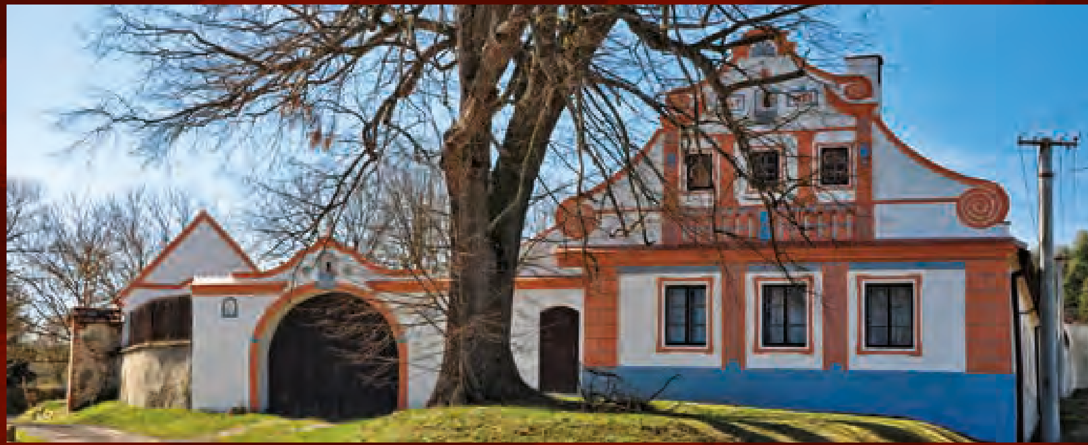
Dobešice (PI), čp. 7, pro region netypické průčelí usedlosti zřetelně ovlivněné blatskou architekturou, datováno 1863
