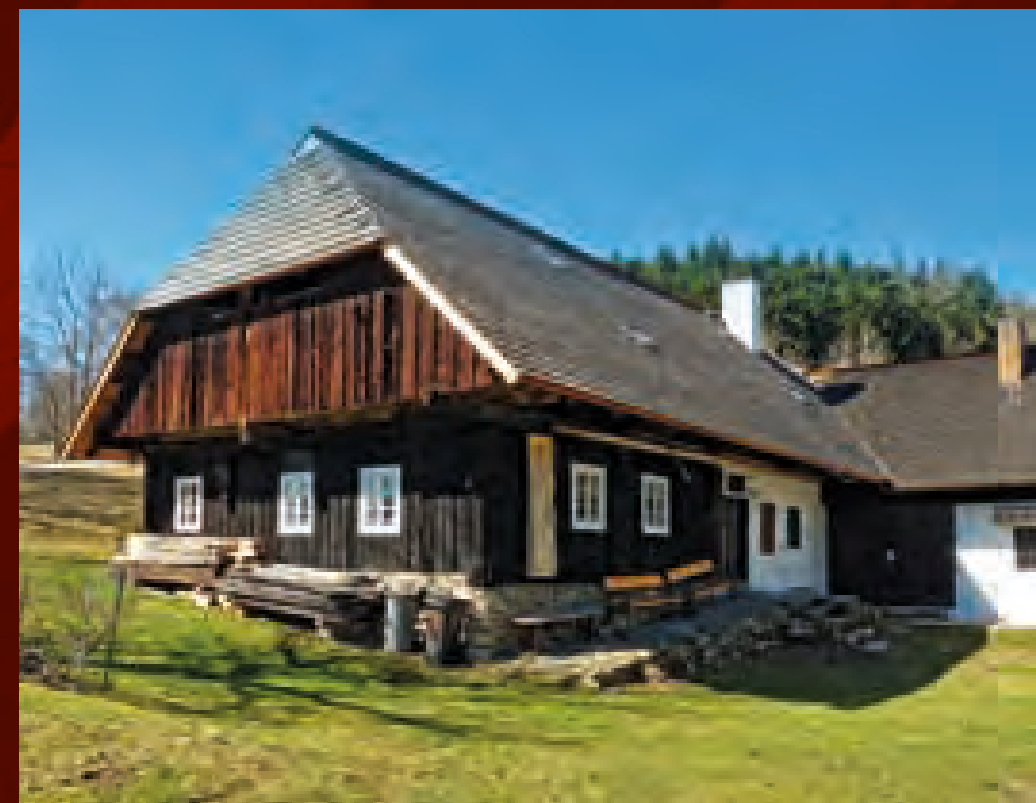
Říhov (PT), čp. 49, klasická šumavská usedlost s trojstrannou dispozicí a roubenou obytnou částí
