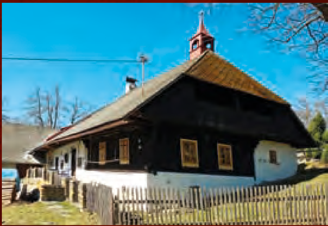
Šebestov (PT), čp. 105, tzv. Holečkův statek, datovaný 1851, roubená světnice obložená šindelem, široká polovalbová střecha se zvoničkou v hřebeni, chlév přístupný přímo z obytné části
