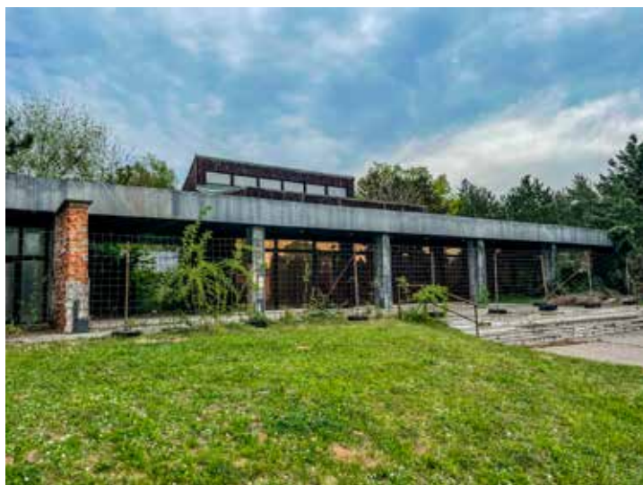
obr. 1: Smuteční síň v Brně – Židenicích, současný stav. Foto Petr Kunc
