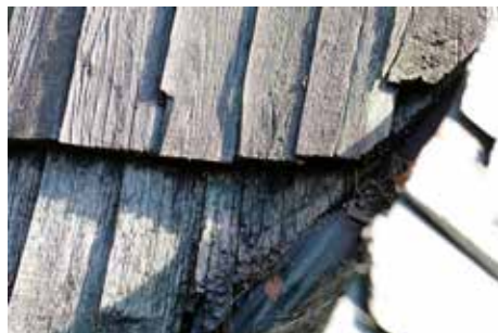
obr. 31, 31a: Špatný stav dřevěných šindelů a úžlabí. Foto Vlasta Loutocká
