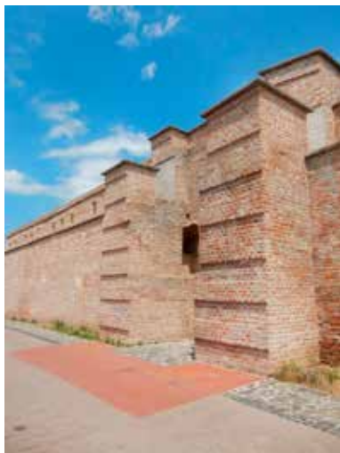
obr. 19: Realizovaná obnova narušených častí veží trnavského opevnenia metódou architektonizovanej ruiny (zdroj: [11])
