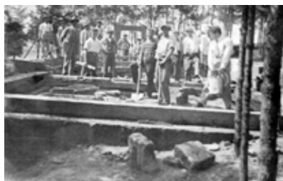
obr. 20: Ze stavby kostela na Husově kopci. Archiv Bohuslav Benč
