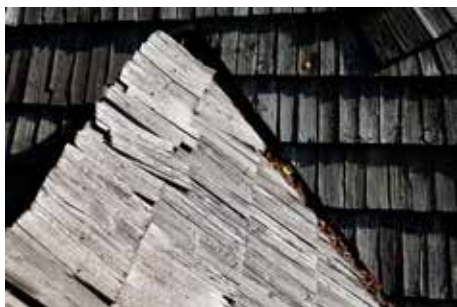
obr. 31, 31a: Špatný stav dřevěných šindelů a úžlabí. Foto Vlasta Loutocká
