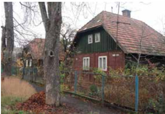
obr. 10: Kolonie Malá Praha, fošnové domy, rok 2013. Zdroj: archiv autorky.
