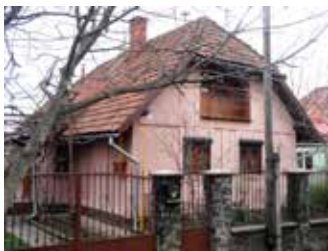
obr. 15: Kolonie Malá Praha, stavební úpravy fošnových domů, rok 2013. Zdroj: archiv autorky.
