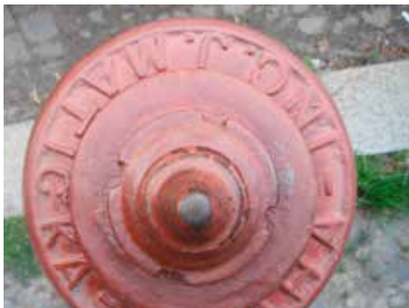
obr. 29: Požární hydrant po obnově, s čitelným nápisem Ing. J. Matička – Praha; rok 2013. Zdroj: Archiv autorky.
