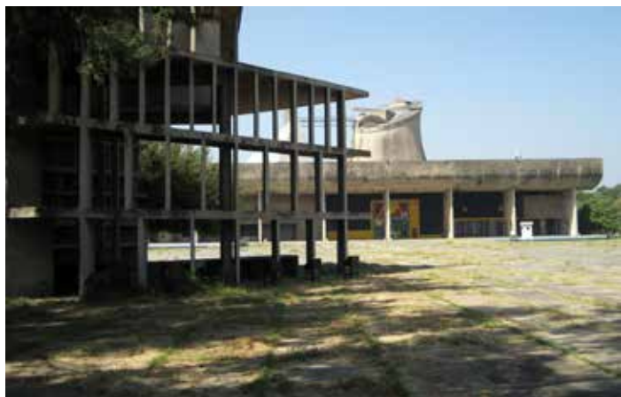
obr. 5: Zanedbané prostory v komplexu Capitol v Čandigarhu. Pohled od Věže stínů na Palác shromáždění. Foto: Hana Urbášková
